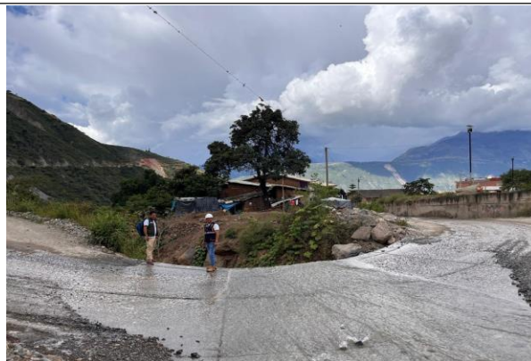
FIGURA N°02: EN EL RECORRIDO SE OBSERVA QUE EL RIO, EN SU MARGEN IZQUIERDA VIENE AFECTADO VIVIENDAS, EROSIONANDO BASES DEL PUENTE.
