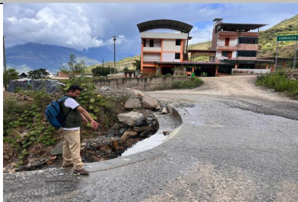
FIGURA N°01: RECORRIDO E IDENTIFICACION DE TRAMOS CRÍTICOS DESDE EL PUNTO DE INICIO, DONDE SE PUEDE VISUALIZAR QUE EL RIO EN SU MARGEN IZQUIERDA AFECTADO A CULTIVOS, EROSIONANDO TERRENOS EN MAXIMAS AVENIDAS.
